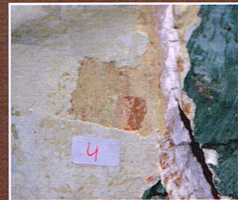
Stratigrafisch venster, van rechts naar links: terracotta, origineel, tweede interventie, derde interventie
